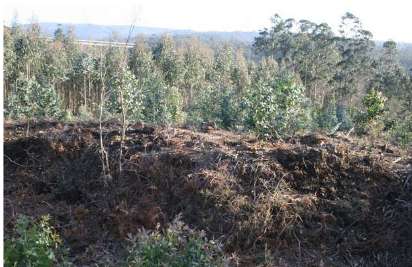
Eucaliptos con remocións de terra no foxo e no parapeto
